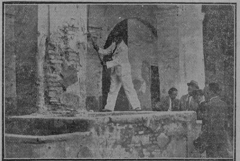
El Alcalde iniciando el derribo.
