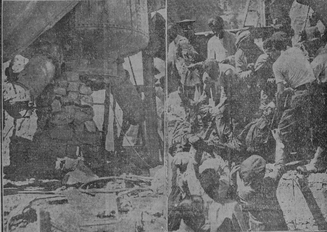
Parte del compresor que hizo explosión, ocasionando la muerte del encargado José Montenegro y las heridas que sufren los nueve obreros.—Momento en que era sacado el cadáver del desgraciado Montenegro.
