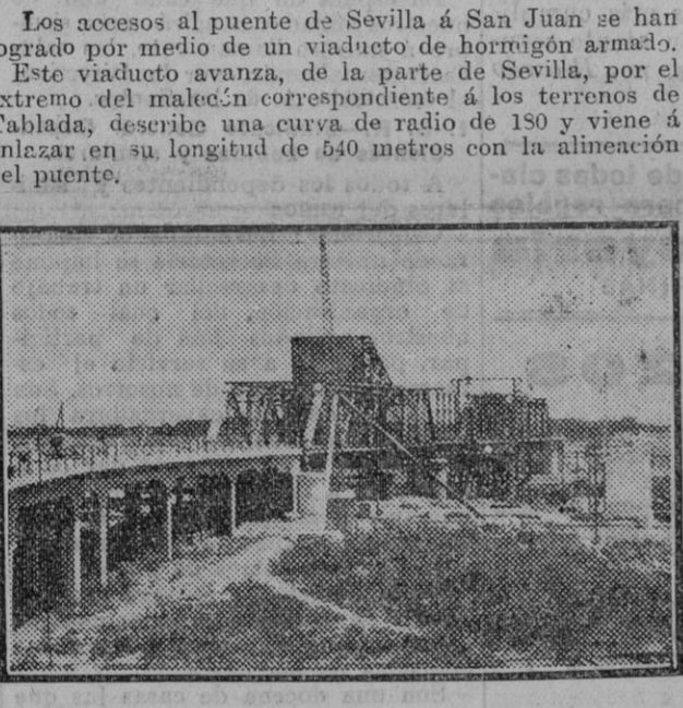
Estado actual de las obras de construcción del puente metálico, con el que unen los dos trozos del viaducto a San Juan de Aznalfarache.
