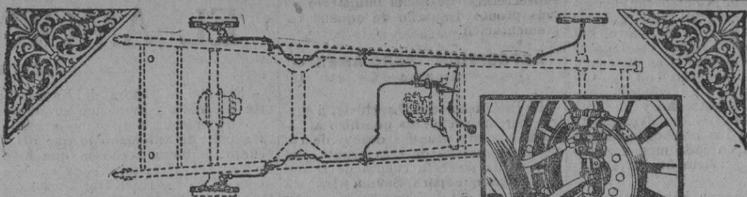
Frenos hidráulicos sistema Lockheed sobre cuatro ruedas
