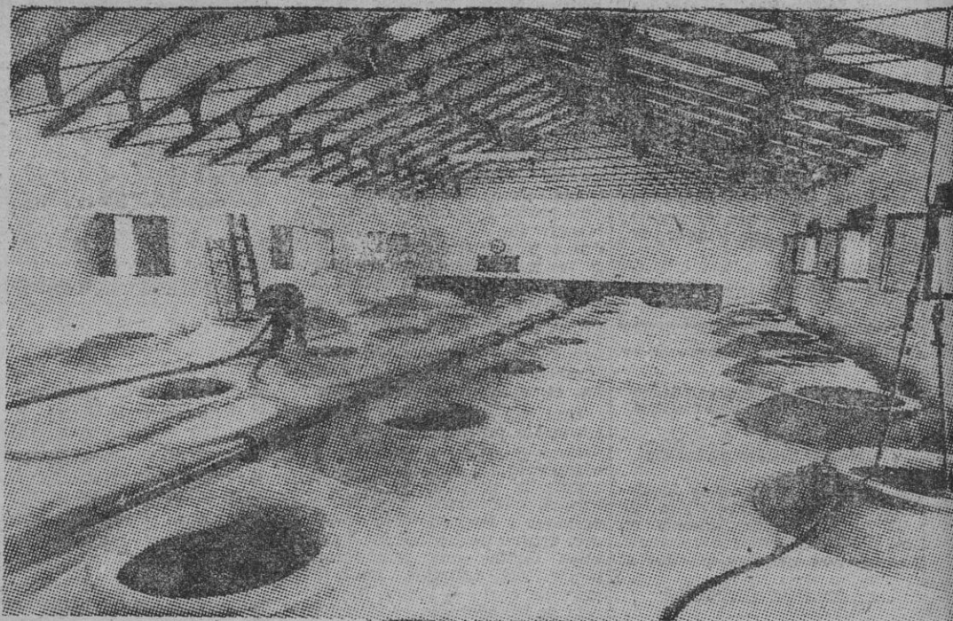
Vista parcial de una nave.
