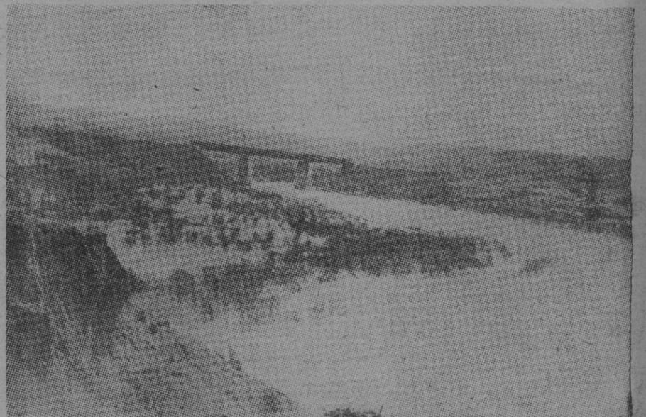
Puente del ferrocarril sobre el Genil, averiado por la desviación de sus muros centrales. Al lado, la aldea de El Palomar, de Puente Genil. (Foto Ríos.)
