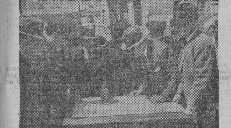
El conde de Vallellano examinando las obras de la carretera de Madrid a Francia, prolongación de la barcelonesa calle de Aragón (Foto Archivo)
