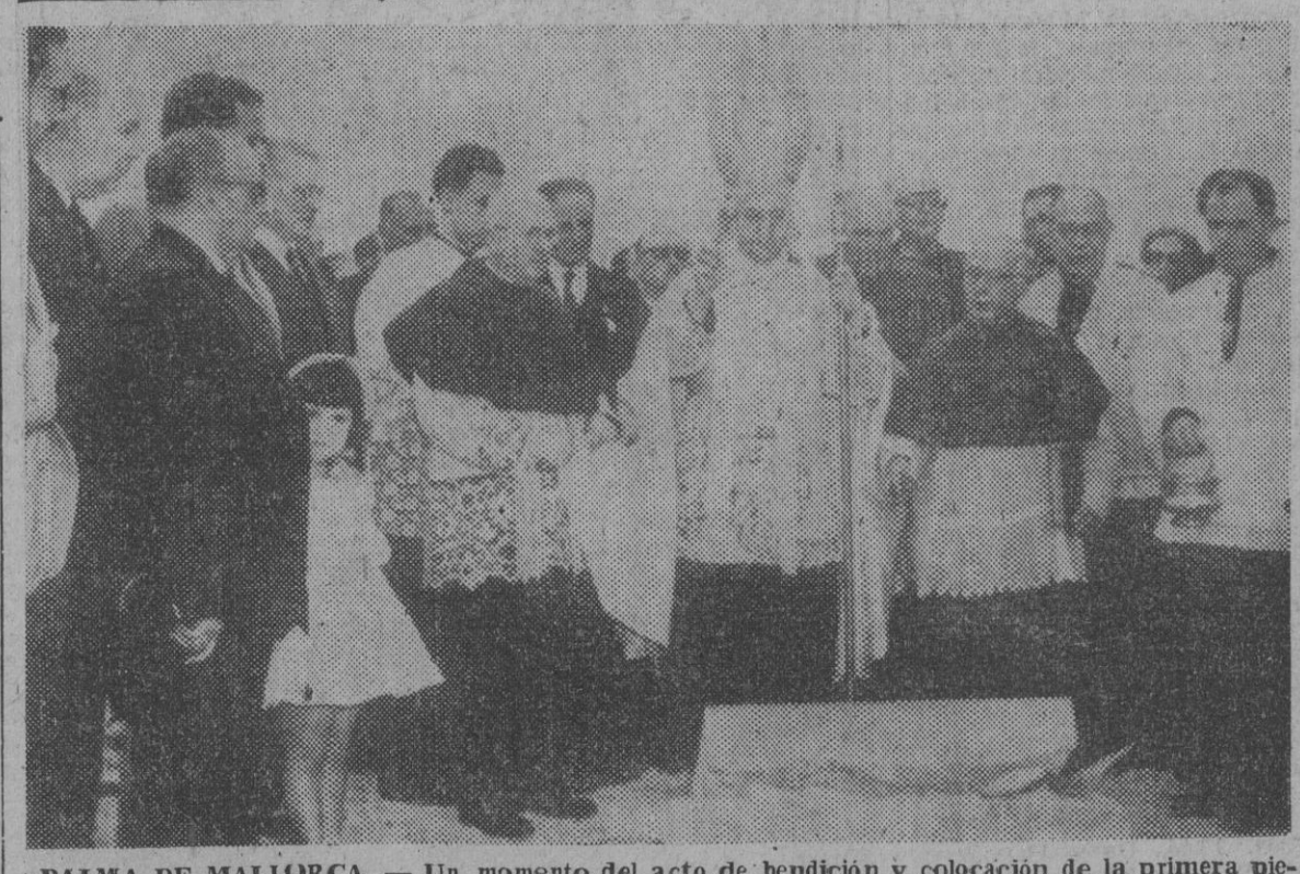
PALMA DE MALLORCA. — Un momento del acto de bendición y colocación de la primera piedra de los terrenos que ocuparán las viviendas veraniegas para periodistas en la playa de Palma Nova. Efectuó la bendición el obispo de Mallorca y al acto asistió el director general de Prensa, don Juan Aparicio. — (Foto Cifra)
