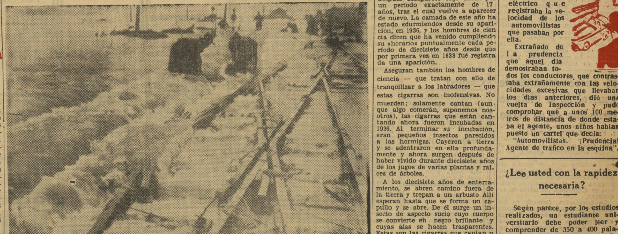
SALVAMENTO DE MATERIAL FERROVIARIO. — Obreros japoneses trabajan en el salvamento de material ferroviario, después de las inundaciones ocurridas en la isla de Kyushu.
