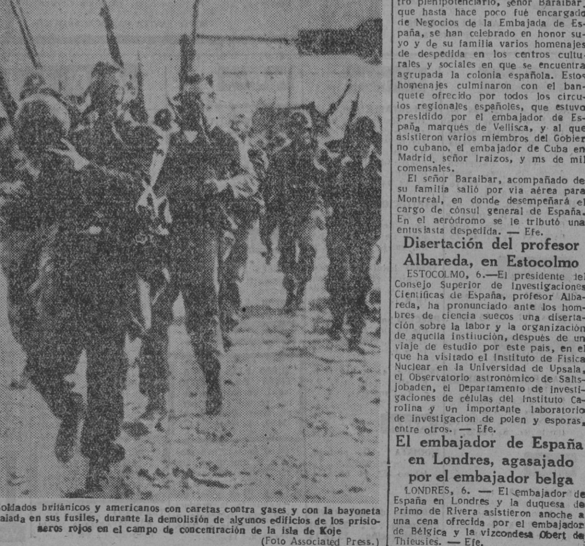
Soldados británicos y americanos con caretas contra gases y con la bayoneta cajada en sus fusiles, durante la demolición de algunos edificios de los prisioneros rojos en el campo de concentración de la isla de Koje. (Foto Associated Press.)
