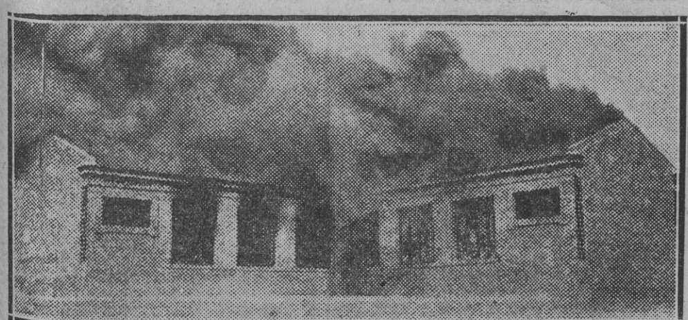
MADRID :: Hazanas de los supervividos de Madrid. Vista del grupo escolar del Cerro del Aire, cuando las llamas lo envolvieron haciendo inútiles los esfuerzos de los bomberos.
