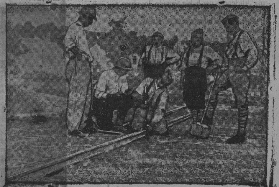
Construcción de un puente sobre el Mosa.—(Fot. Inf.)
