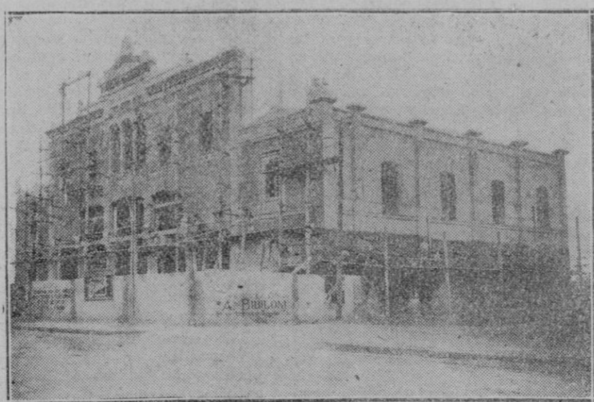
Expléndido Garsga que para la venta y exposición de autos está construyendo el conocido industrial don Antonio Biblioni en la calle de Aracón, cuya distribución es notable.
