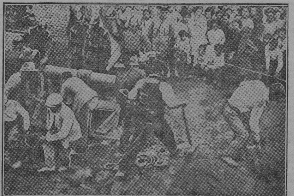
Los bomberos trabajando, auxiliados por una brigada de obreros, para salvar a un operario que quedó sepultado por un desprendimiento de tierras, en Madrid.
