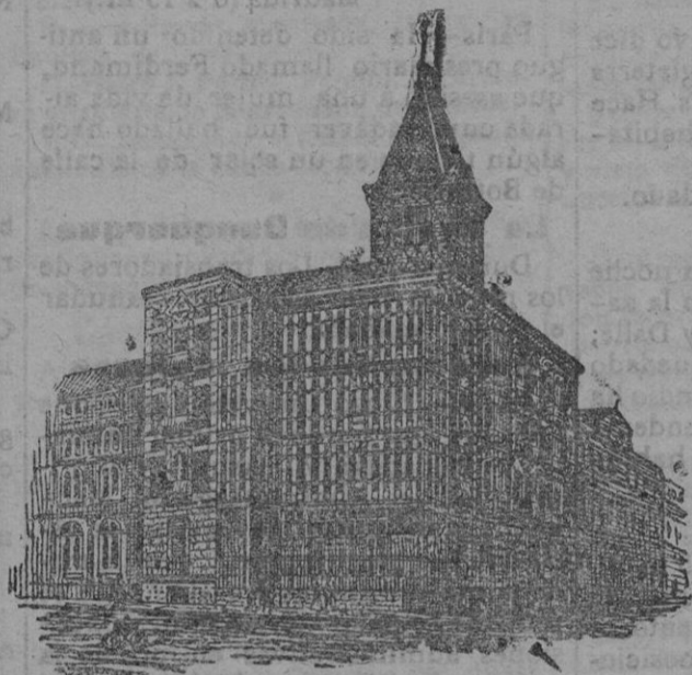
Edificio propio de la Sociedad en Pamplona
