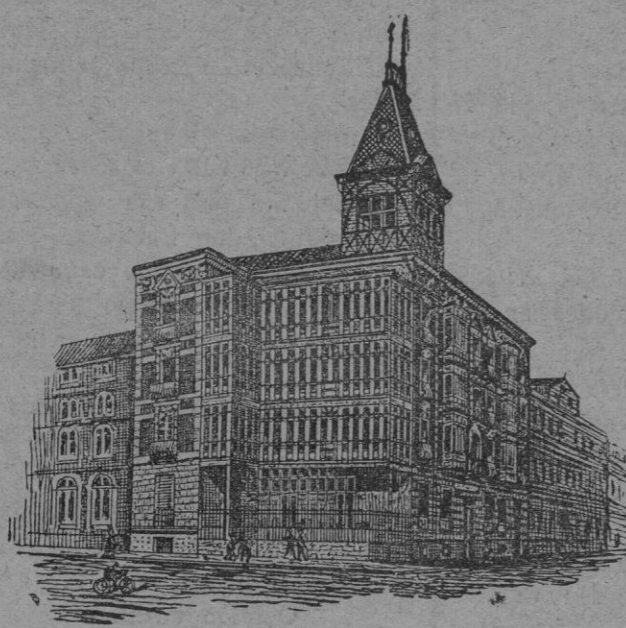
Edificio propio de la Sociedad en Pamplona
