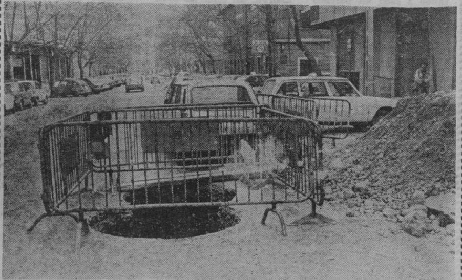
La imagen corresponde a la calle Suau Saiz, donde se puede apreciar la excavación en ocho que ha debido practicarse para reparar la alcantarilla estropeada por la zanja que la Telefónica abrió en la zona. Esta obra, en marcha, será terminada en el transcurso de la próxima semana. (Foto Juanet)
