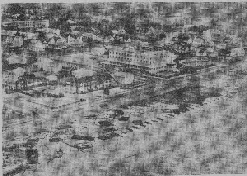
ATLANTIC CITY, New Jersey. — En este estado ha quedado el paseo marítimo de Atlantic City tras el paso de «Belle» por la localidad. Los daños causados por el huracán son menores de lo que se esperaba. Se reducen a pequeñas inundaciones, algunos tejados arrancados, a vallas tiradas. — (TELEFOTO CIFRA GRAFICA)
