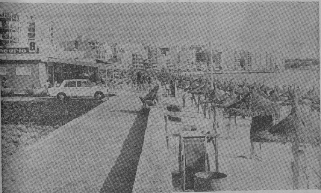
Únicamente esta zona, la más oriental de la Playa de Palma, presenta ligeros síntomas de contaminación. El problema quedará solucionado en gran parte con la puesta en funcionamiento de la primera fase de la depuradora del Ayuntamiento de Llucmajor, a primeros de agosto.
