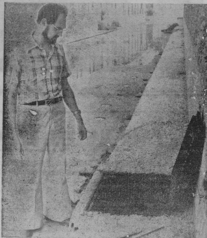
El señor Bigas nos muestra las bocas de las alcantarillas a donde van canalizadas las aguas residuales de la fábrica de curtidos. Bajo nuestro punto de vista, el problema está más abajo, junto al mar.
