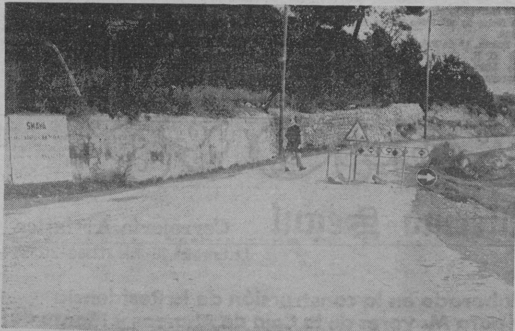
El único desvío señalizado que existe en este increíble marathon. El camino de Torrenera que discurre junto a las obras de la futura autopista conduce directamente a Cala Mayor, frente al Nixe Palace.
