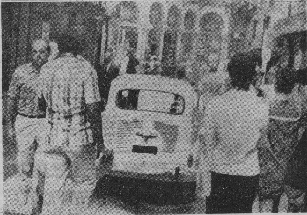
LA CALLE JAIME II, LA MÁS IMPORTANTE VIA COMERCIAL DE LA CIUDAD, SE VE EN SU PARTE BAJA CONSTANTEMENTE IMPEDIDA POR LOS VEHICULOS OBLIGADOS A ATRAVESAR UNOS CUARENTA METROS DE SU RECORRIDO.
