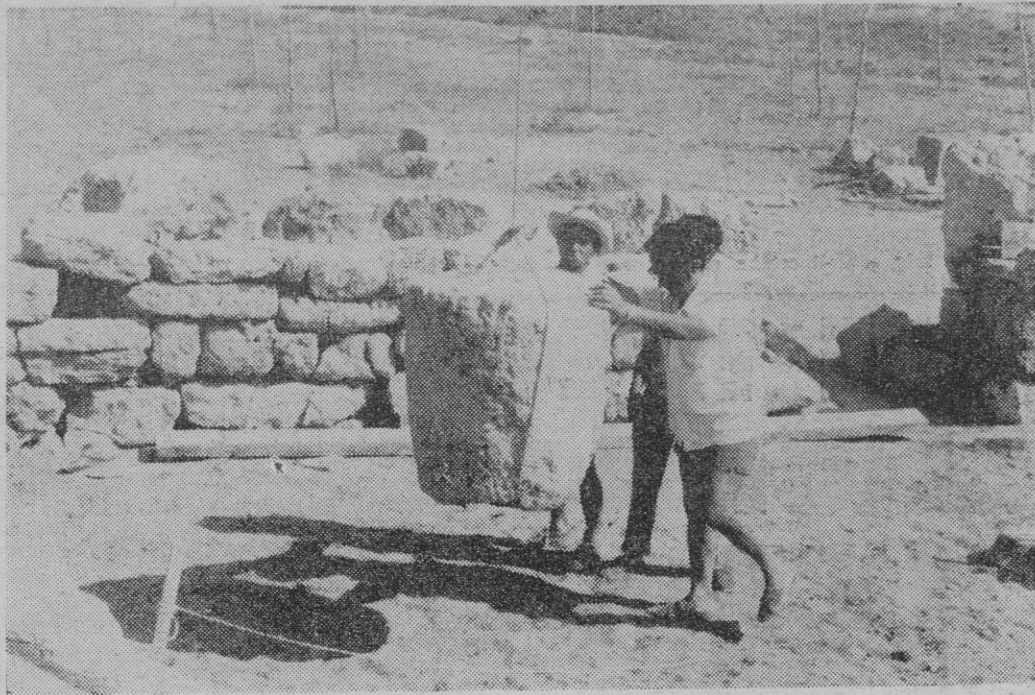
Una de las últimas fases de la reconstrucción del Santuario del poblado talaíótico de So N'OMS fue la colocación de sus columnas. Aquí vemos al director de los trabajos el señor Rosselló Bordoy, arrimando el hombro en la colocación de una de las columnas. — (Foto Mascaró Pasarius).
