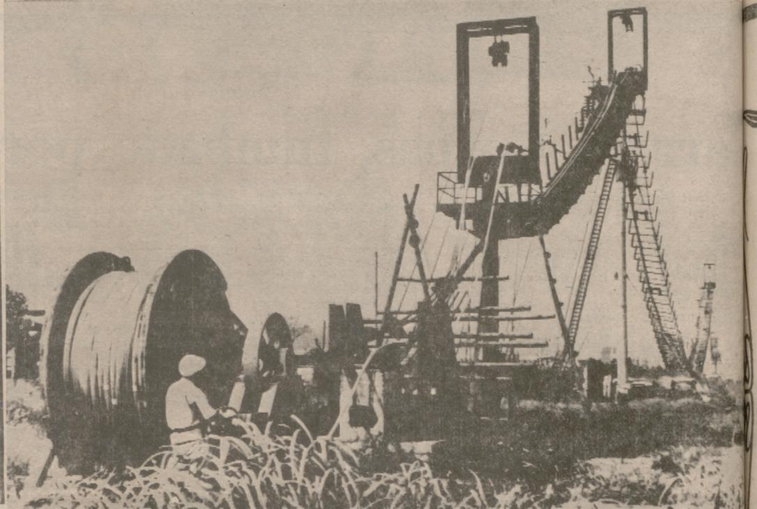
Un nuevo método de suspensión de puentes se prueba por vez primera en Japón. El método consiste en un grueso cable entre dos puertas en altura para sujetar el puente que va suspendido. Ciento cincuenta y ocho metros de puente cuestan con este método unos 140.000 dólares.
