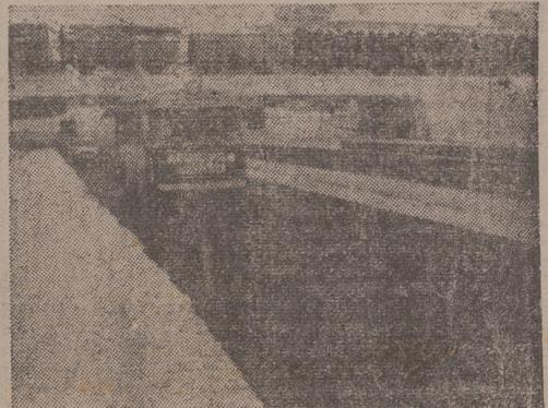
En un tramo de 150 metros de una calle de Odense se han instalado tubos de plástico a través de los cuales se mantienen ocultos por el frío 40 grados Celsius, que permanecen ocultos por el asfalto y que eliminan la nieve depositada sobre él. El invento parece eficaz, aunque costoso, para las pendientes. En la foto, el trozo experimental completamente libre de nieve, mientras la circulación transita por él con normalidad.—(Foto Fiel).
