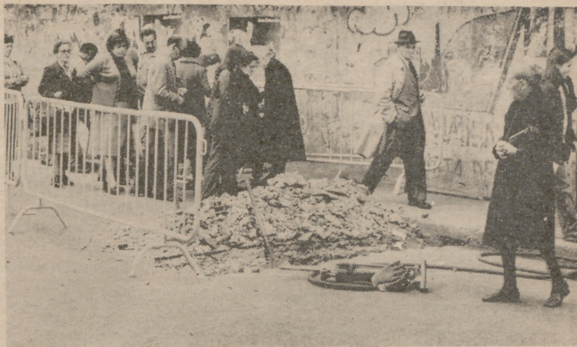
El «pasillo» de la calle Santiago.
