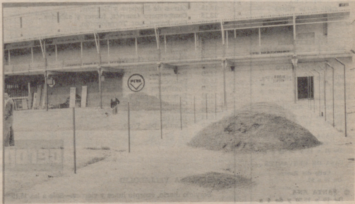
OBRAS DE INSTALACION DEL CANODROMO
