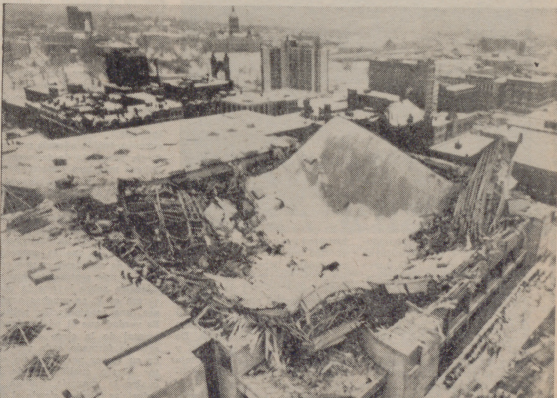
HARTFORD (Connecticut, Estados Unidos).—Unas 5.000 personas abarrotaban el Centro Cívico de Hartford, presenciando un partido de baloncesto, poco antes de que el techo del edificio se derrumbara. En la foto se aprecia el estado en que quedó el Centro tras el derrumbamiento. (Telefoto Cifra Gráfica)
