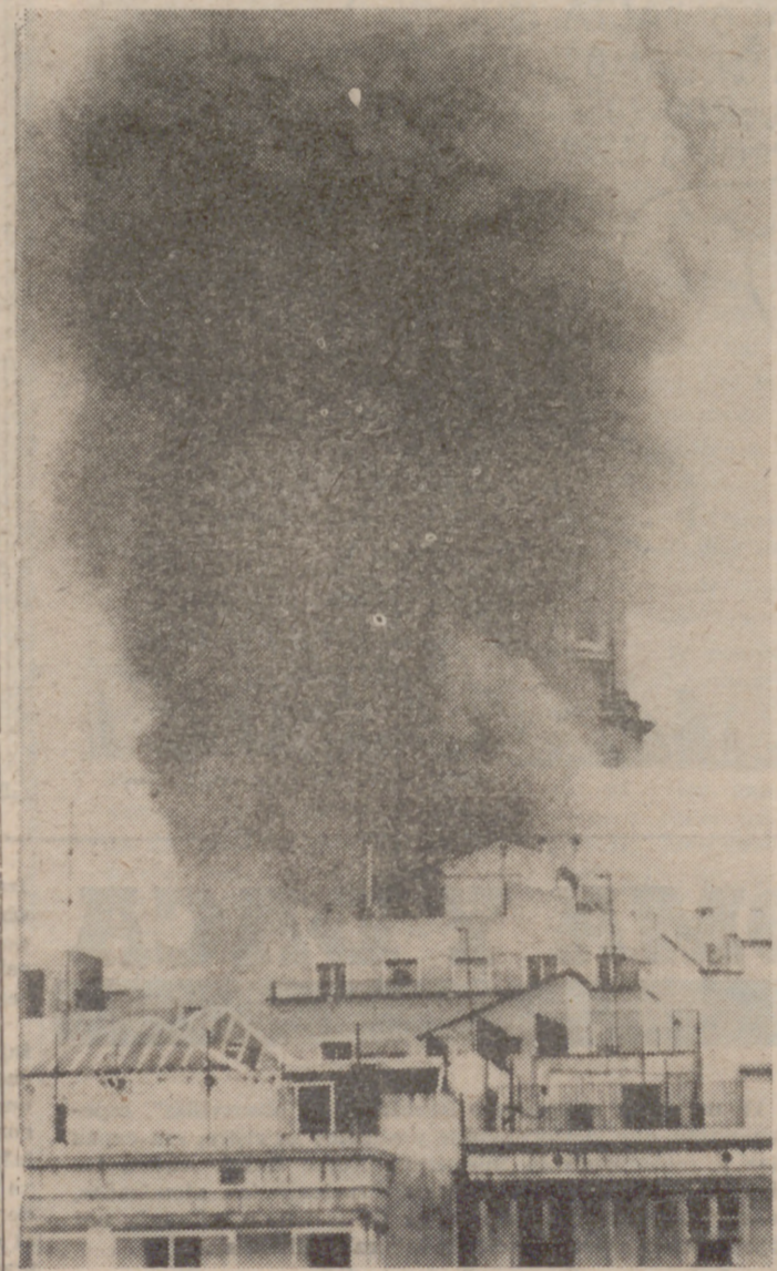
BARCELONA.—Un importante y espectacular incendio se produjo en la mañana de ayer en el centro de la ciudad, afectando al edificio «Torrens», enclavado en la Avenida de José Antonio. El fuego, al parecer, se inició en los sótanos del citado edificio, tomando un rápido incremento, dada la combustibilidad de las materias almacenadas. Parte del edificio se derrumbó a consecuencia de las llamas. Las pérdidas se calculan en varios cientos de millones de pesetas. (Telefoto-Cifra Gráfica)
