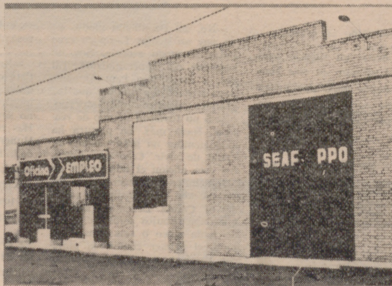
Fachada de la Oficina de Empleo de Carmona (Sevilla).
