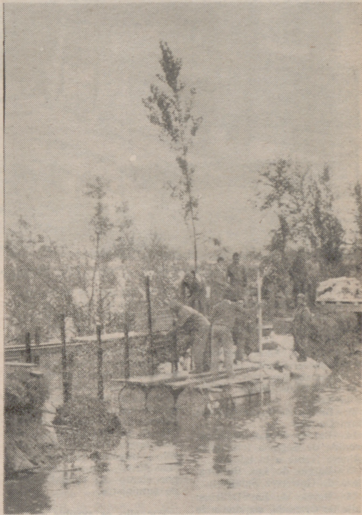
TRABAJOS DE ENCOFRADO
