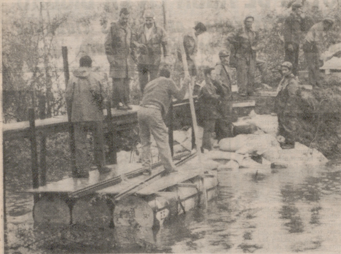
UN MOMENTO DE LOS TRABAJOS DE REPARACION
