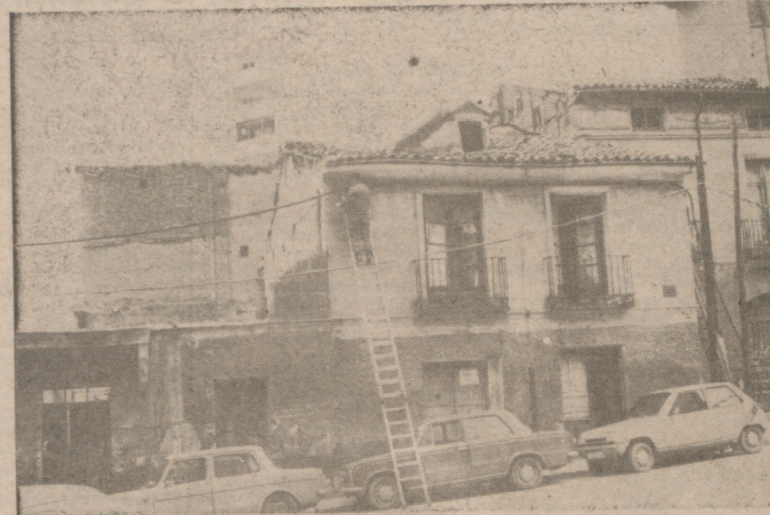
Ya hace tiempo que le tocó el turno a la Plaza del Rosarillo, uno de los viejos rincones más típicos — y más viejos — de la ciudad. La piqueta, ahora, sigue su obra implacable y los antiguos edificios van desapareciendo, con prisa y sin pausa, para ofrecer, no tardando, para ir ofreciendo ya, en realidad, una fisonomía nueva y distinta dentro de una línea urbanística actual que debería proyectarse más hacia un futuro inmediato. Mientras, las últimas casas de la Plaza del Rosarillo van convirtiéndose en solares — preciados solares — sobre los que pronto se erguirán las nuevas edificaciones.—(Foto Carvajal.)
