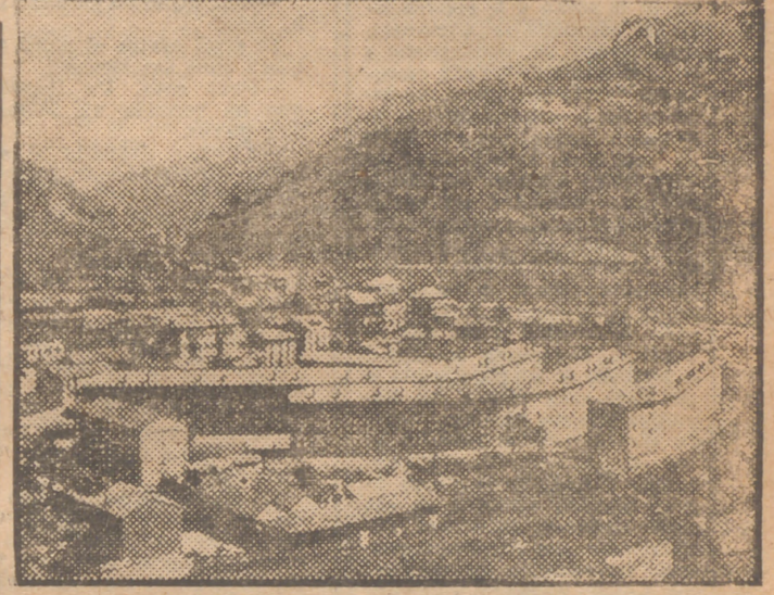
Perspectiva del magnífico grupo de viviendas protegidas, de renta modesta, construido e inaugurado en Lada, en la cuenca minera asturiana
