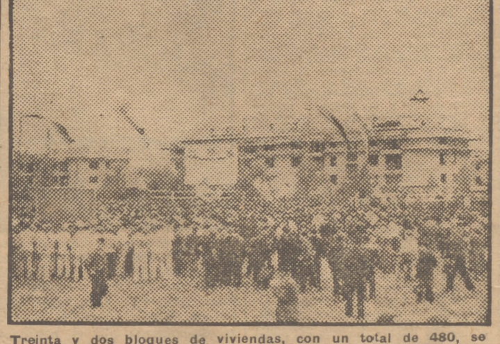
Treinta y dos bloques de viviendas, con un total de 480, se están construyendo en las inmediaciones de Francfort del Main. De esta forma se trata de remediar el grave problema de la vivienda, agudizado en Alemania por las destrucciones de la guerra. En la fotografía, una vista del acto con motivo de ser puesto el tejado a uno de los bloques. (Foto Giffa.)
