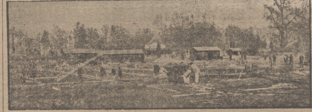
Comenzado en Estrasburgo las obras de construcción del futuro palacio del Consejo de Europa. El grupo de edificios deberá estar terminado en junio, ya que la sesión inaugural del Consejo habrá de celebrarse a mediados de julio. (Foto A. P.)
