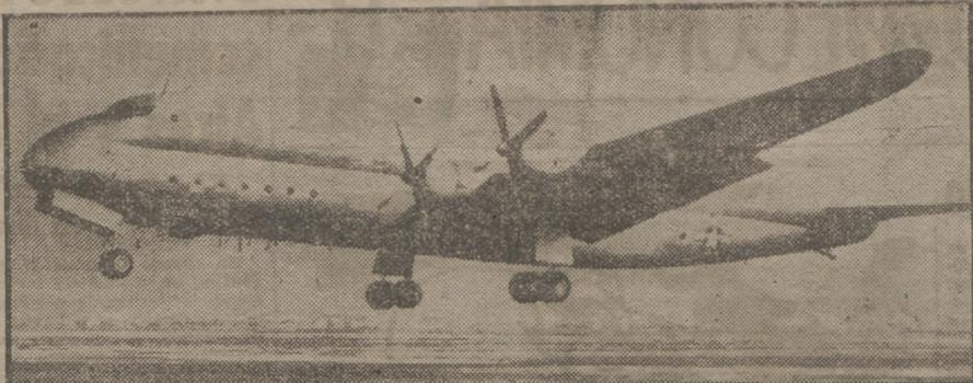
En Burbank (California) ha realizado su primer vuelo de pruebas el "Constitution", avión metálico de 92 toneladas y doble cabina. Ha sido construido por la Lockheed Aircraft Company y puede transportar 180 pasajeros. (Foto A. P.)
