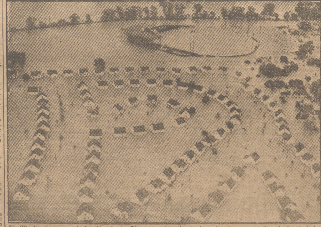
El 23 de mayo se desbordó el río Chemung, inundando las dos terceras partes de la ciudad de Elmira. En la foto se ven los efectos de la inundación en un nuevo barrio de casas económicas. Al fondo, el terreno de baseball convertido en piscina.
