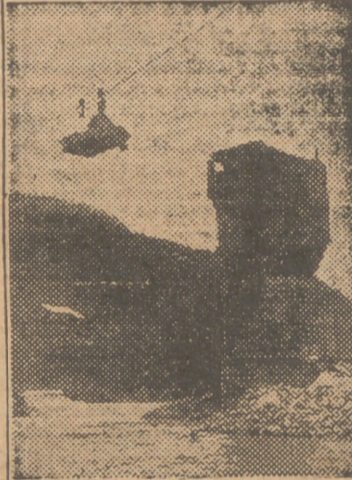
La industriosa zona del Ruhr es objeto de encontrados proyectos sobre su régimen futuro. La fotografía recoge un aspecto de la zona minera: un transbordador aéreo de mineral. (Foto A.)
