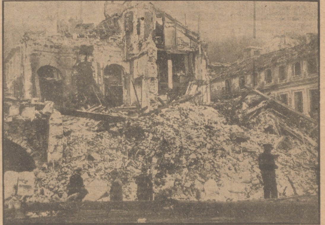
... las calles en ruinas, colmadas de escombros...
