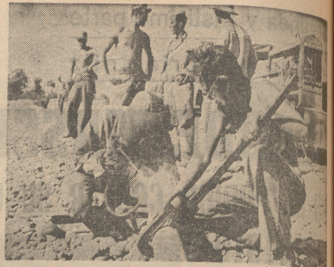
Los soldados norteamericanos, en Birmania, soldando un trozo de tubería que forma parte de la construcción de un oleoducto de 3.200 kilómetros, ya habilitado desde Calcuta al aeródromo de Yunnan, en China
