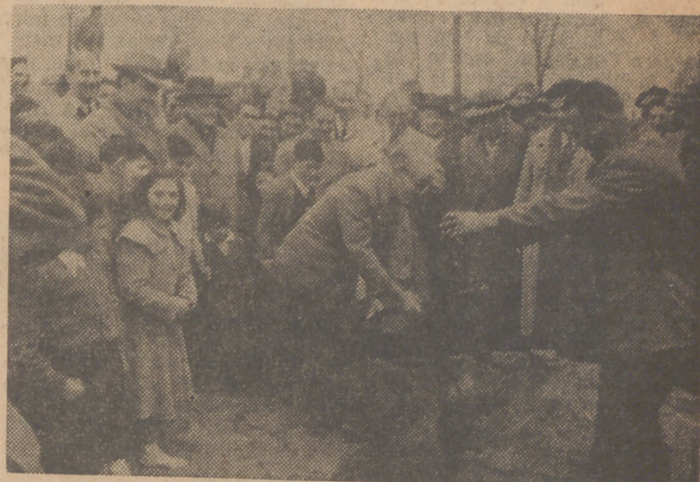
En La Cabrera, el pueblo serrano en que tenía su finca para los fines de semana. Jiménez Díaz planta un árbol del nuevo Coto Escolar en presencia de las autoridades locales y provinciales
