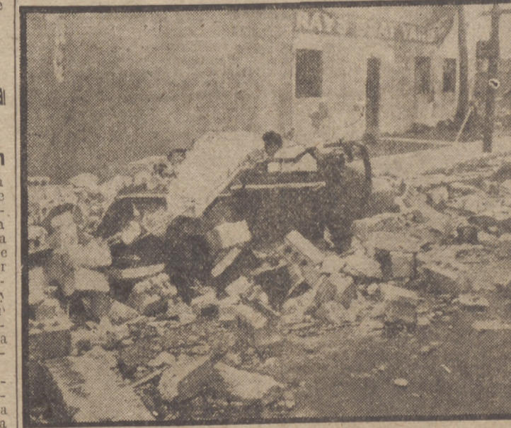
La furia del ciclón Los dos ocupantes de este coche resultaron con graves heridas al caer sobre el vehículo los grandes bloques de piedra que se ven en la fotografía, y que se desprendieron de la parte superior de un edificio por efecto del terrible huracán que se dejó sentir recientemente sobre Miami. El fenómeno ha sido el peor que se registra en aquellas tierras desde 1926, y ha causado daños muy considerables
