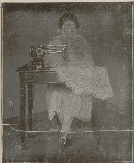
Máquina eléctrica sobre Mesa núm. 40, accionando
