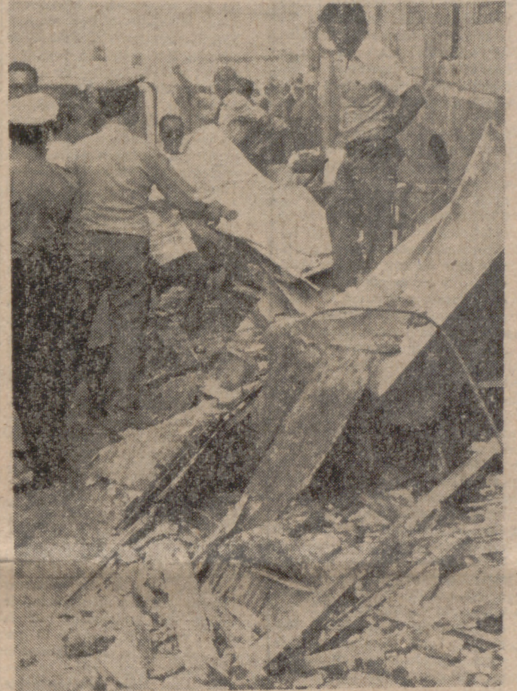
MADRID.—Dos momentos de los trabajos de los bomberos y equipos sanitarios entre los escombros de la cafetería donde se produjo la explosión.—(Fotos Cifra Gráfica.)
