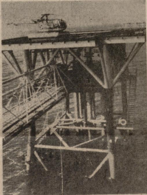
AMPOSTA (Tarragona).—Vista general del pozo "Amposta Marino C-1", donde se llevan a cabo los trabajos de montaje de la maquinaria necesaria para la producción petrolífera sobre las ya instaladas plataformas, situadas a veinte metros sobre el nivel del mar.—(Telefoto Cifra Gráfica.)
