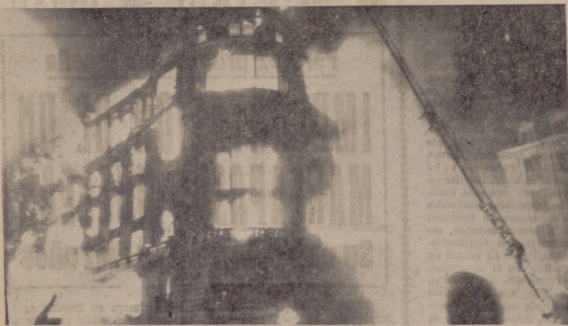
PARIS.—Un incendio ha destruido el edificio en que estaba instalado el "Drugstore" de los Campos Eliseos de París, muy cerca del Arco del Triunfo. Unas 300 personas se hallaban en el inmueble al declararse el siniestro, pero pudieron ser evacuadas a tiempo y no hubo que lamentar desgracias personales.—(Telefoto Cifra Gráfica-Upl.)
