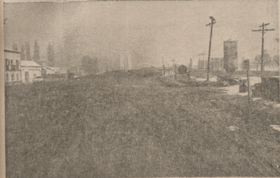
El nuevo trazado de la carretera de Madrid, sobre el ferrocarril de Ariza.
