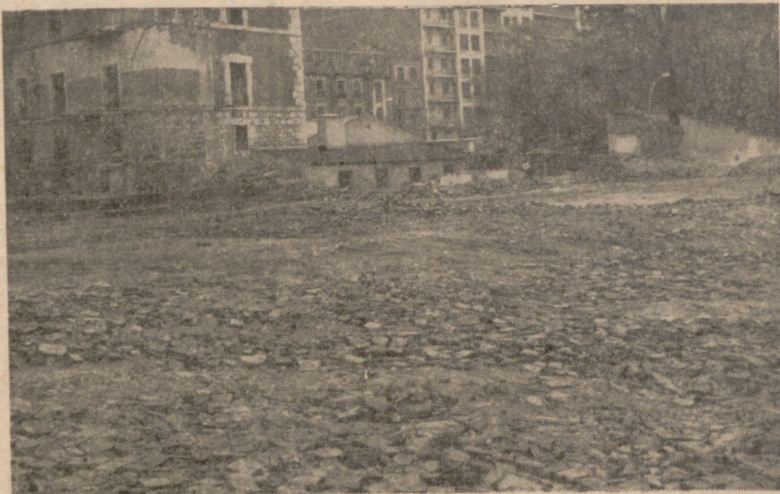
En este solar, futura calle de San Quintín, irán las galerías de alimentación.
