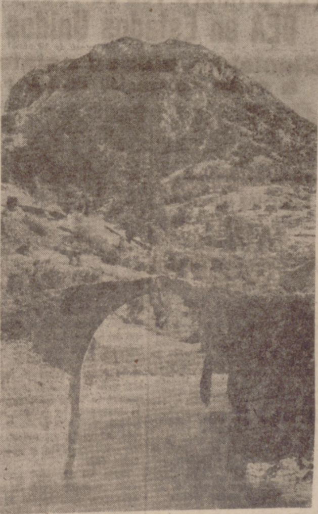
PUENTE DE LA VIDRE, EN TRESCARES (RIO CARES)
