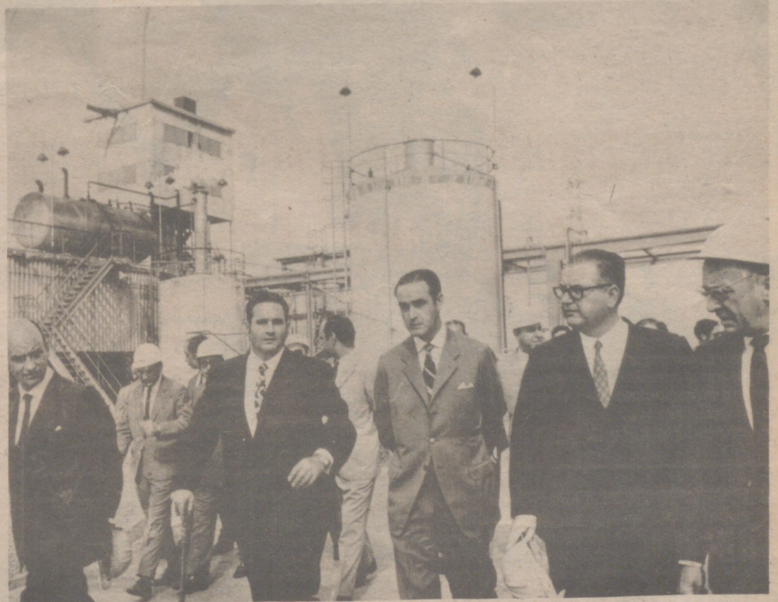
HUELVA.— El ministro de Industria, Sr. López de Letona, ha visitado las instalaciones del polo de desarrollo industrial de Huelva, donde ha inaugurado doce nuevas industrias, señalando a los empresarios la necesidad de la concentración de sus instalaciones industriales como un posible medio de acceder a las dimensiones que el mercado y la técnica exigen hoy día. En la foto, el Sr. Lopez de Letona durante su visita a la planta de polifosfatos de Odiel Química.—(Foto Cifra).
